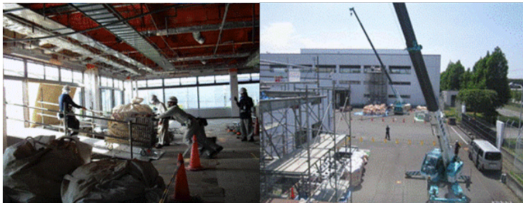
急ピッチで進められた復旧作業
